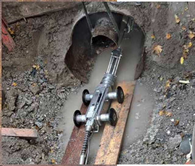
Tag und Nacht war der Höchst-Druckwasserstrahl-Roboter im Einsatz, um den Weg für die Leitungen frei zu machen.
